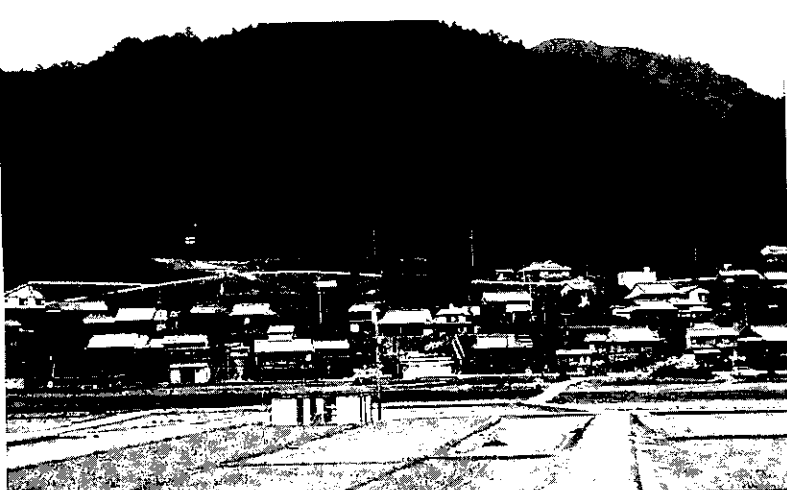
浅里の集落。いちばん低い所にある家の1階屋根まで冠水し、収穫後の水田は土砂に覆われた
